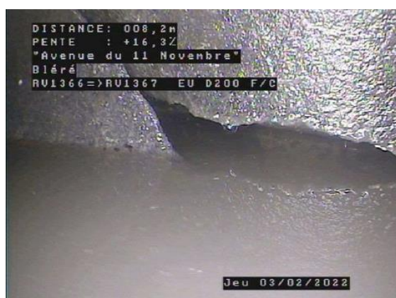
Dégradation de surface - Paroi manquante Avenue du 11 Novembre - Bléré
