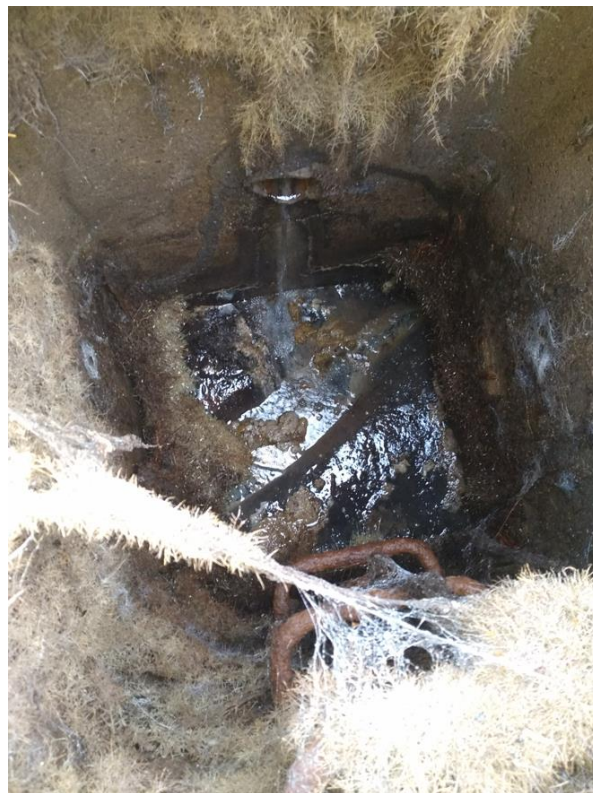
Racines et infiltration – 5 rue Bretonneau à Chenonceaux
