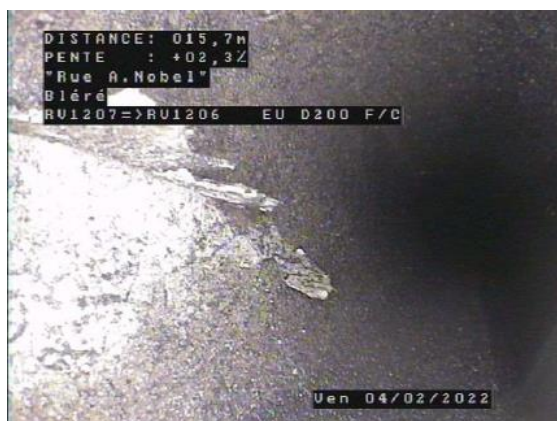
Dégradation de surface - Granulats déchaussés Rue A. Nobel - Bléré
