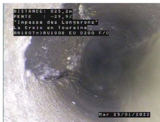
Infiltration - Jaillissement Impasse des Longerons – La Croix-en-Touraine
