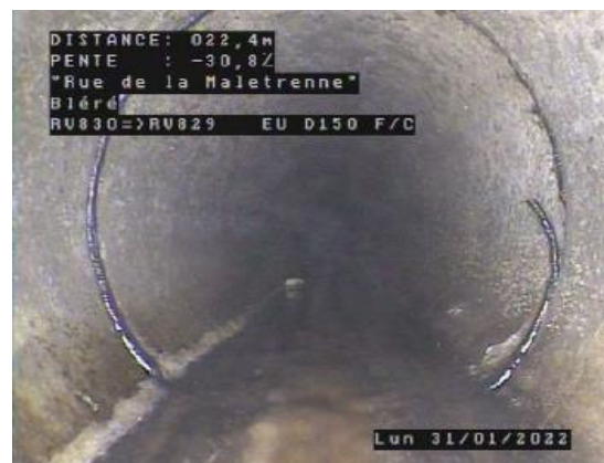
Joint d'étanchéité apparent – Pénétrant et rompu Rue de la Maletrenne - Bléré
