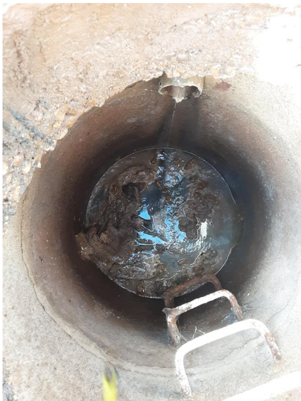
Dépôts – 12 rue du Clos Ferrand à Bléré
