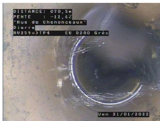
Infiltration - Jaillissement Rue de Chenonceaux - Dierre
