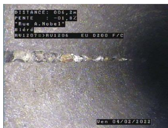
Dégradation de surface - Paroi manquante Rue A. Nobel - Bléré
