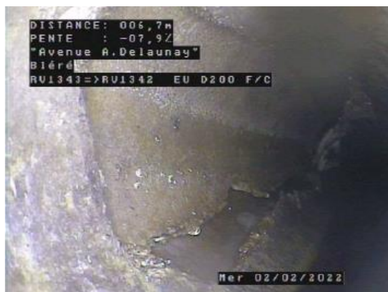
Dégradation de surface - Paroi manquante Avenue A. Delaunay - Bléré
