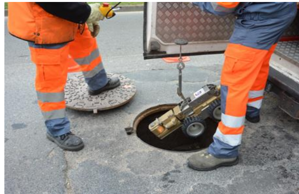
Figure 88 : Principe et matériel utilisé lors des ITV
