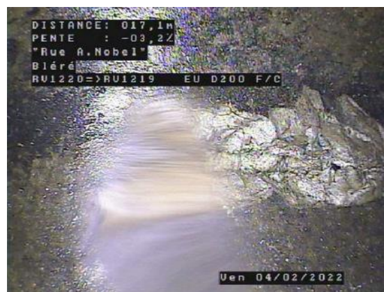
Dégradation de surface - Granulats exposés Rue A. Nobel - Bléré
