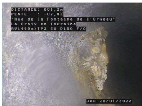
Dégradation de surface - Paroi manquante Rue de la Fontaine de l'Ormeau – La Croix-en-Touraine
