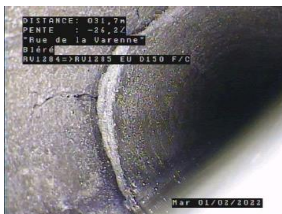
Rupture/Effondrement - Rupture Rue de la Varenne - Bléré
