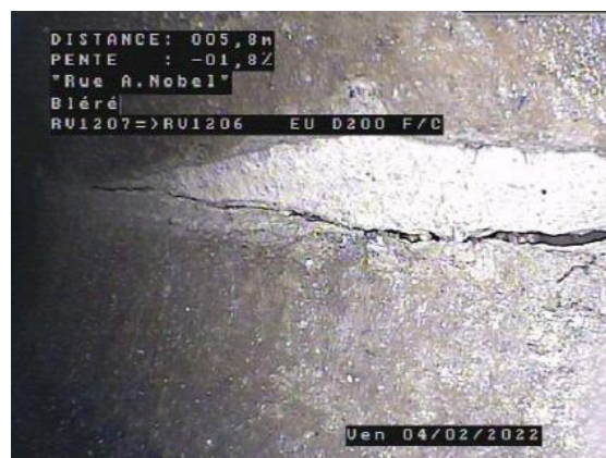
Dégradation de surface - Paroi manquante Rue A. Nobel - Bléré
