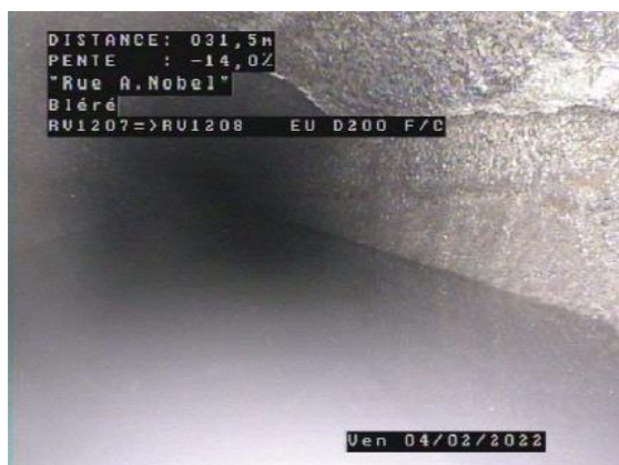
Inspection terminée avant le nœud d'arrivée - Obstruction Rue A. Nobel - Bléré
