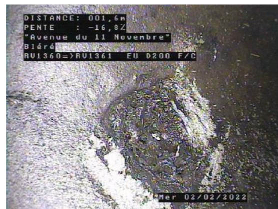
Dégradation de surface - Écaillage Avenue du 11 Novembre - Bléré
