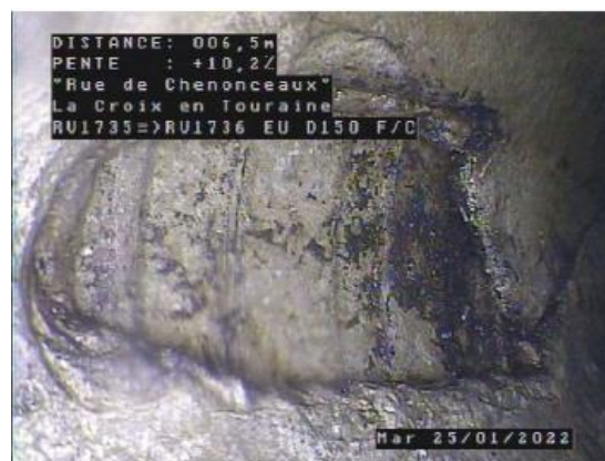
Fissure – Fissure ouverte - Complexe Rue de Chenonceaux – La Croix-en-Touraine
