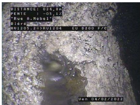
Infiltration - Ecoulement Rue A. Nobel - Bléré
