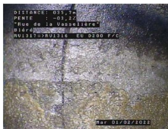
Fissure – Fissure ouverte - Circonférentielle Rue de la Vasselière - Bléré
