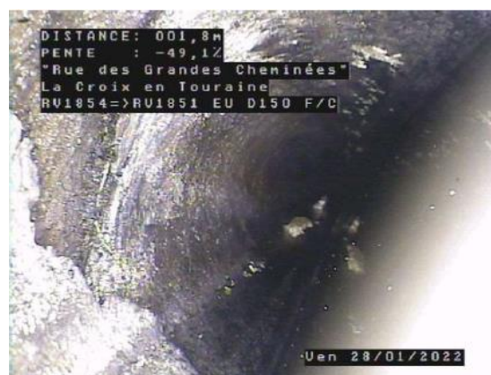
Inspection terminée avant le nœud d'arrivée – Progression impossible Rue des Grandes Cheminées – La Croix-en-Touraine
