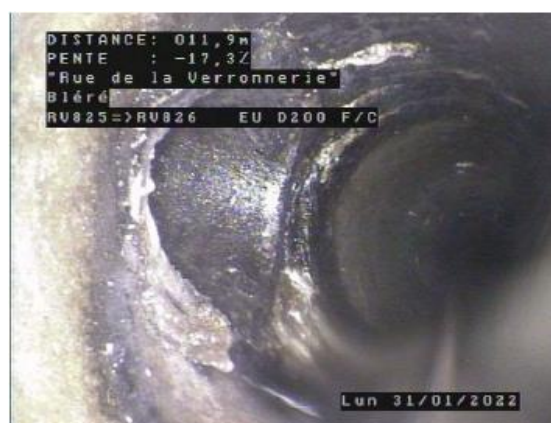
Infiltration – Goutte à goutte à goutte Rue de la Verronnerie - Bléré
