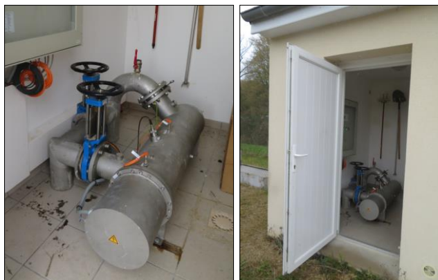
Figure 101 : Poste de relèvement UV – STEU de La Selle-en-Hermoy
