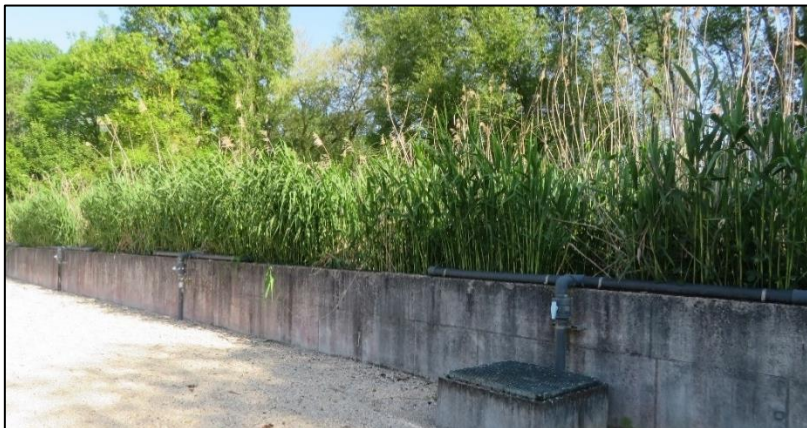
Figure 36 : Lits plantés de roseaux - STEU de Bazoches sur le Betz
