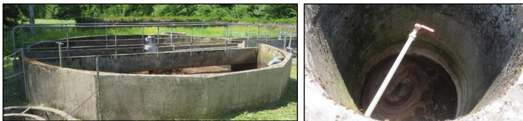
Figure 130 : Bassin d'aération avec dégazeur - STEU de Saint-Firmin-des-Bois
