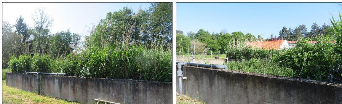
Figure 146 : Lits plantés de roseaux - STEU de Saint-Hilaire-les-Andrésis
