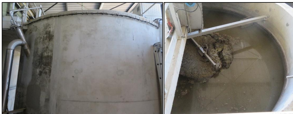
Figure 64 : Dessableur/Dégraisseur - STEU de Courtenay
