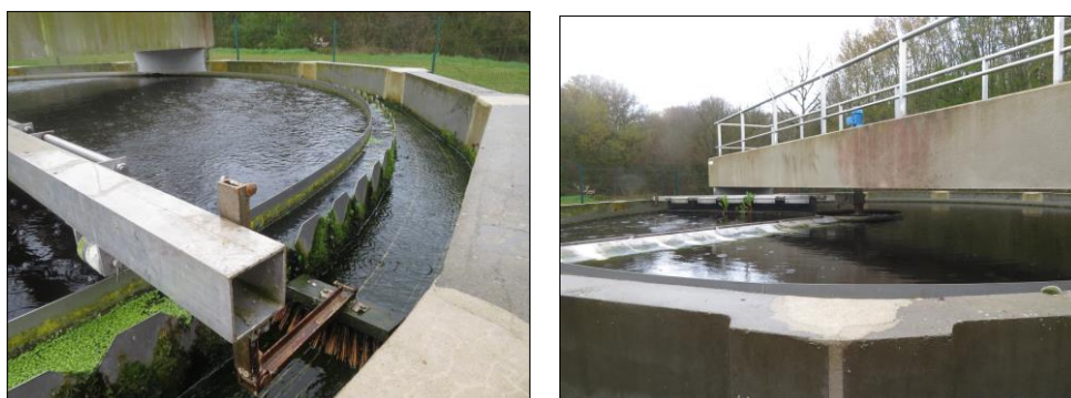
Figure 100 : Clarificateur – STEU de La Selle-en-Hermoy
