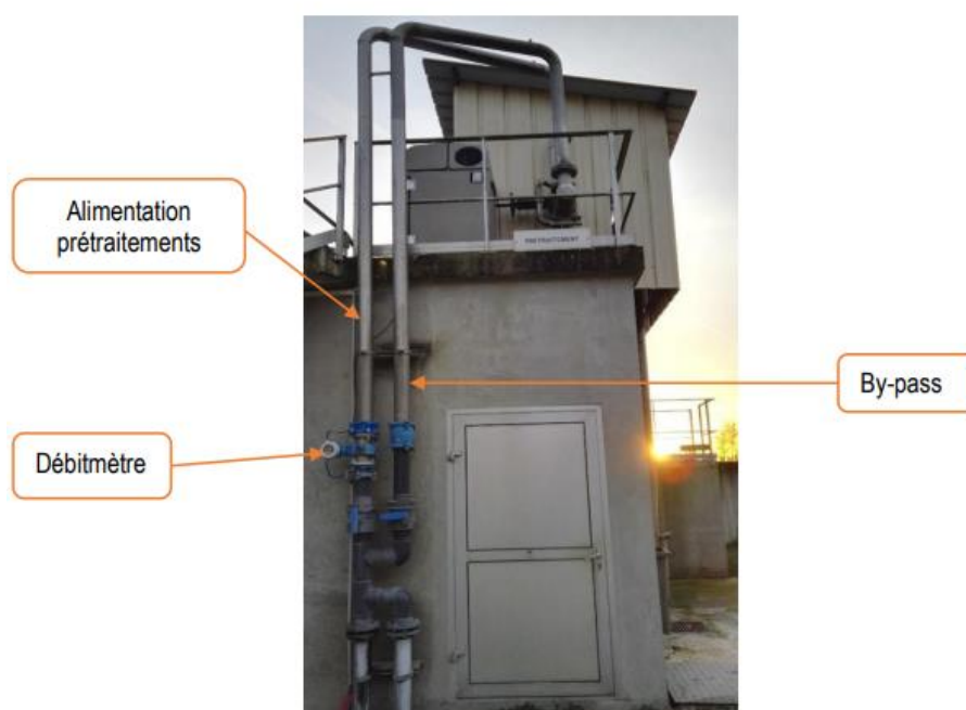
Figure 80 : Arrivée des eaux usées par refoulement (STEU Douchy Montcorbon)
