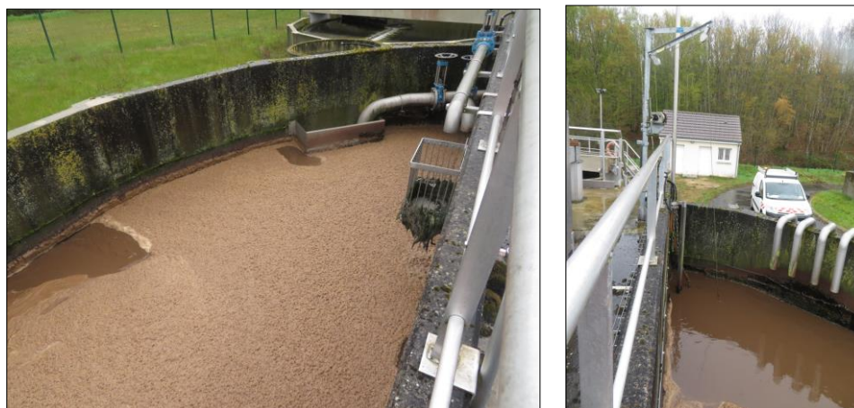
Figure 98 : Bassin d'aération – STEU de La Selle-en-Hermoy
