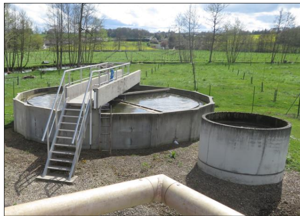
Figure 152 : Dégazeur et clarificateur – STEU de Triguères
