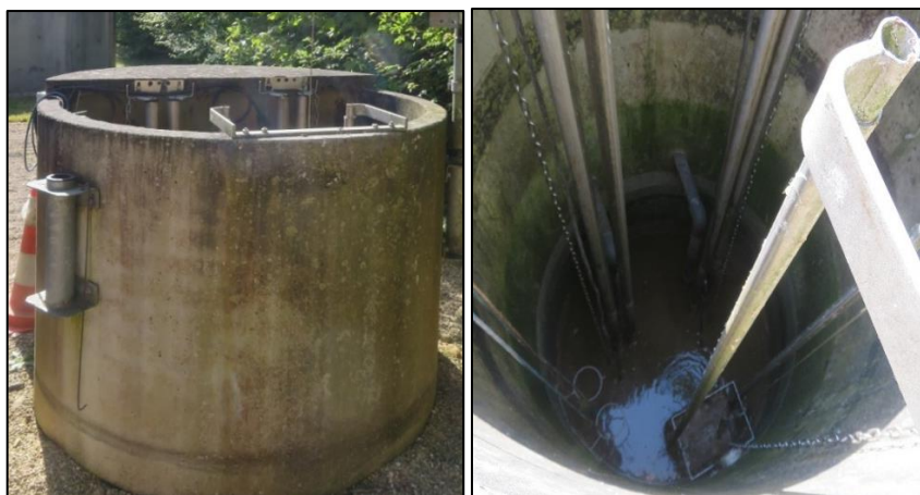
Figure 29 : Poste de relèvement STEU de Bazoches sur le Betz
