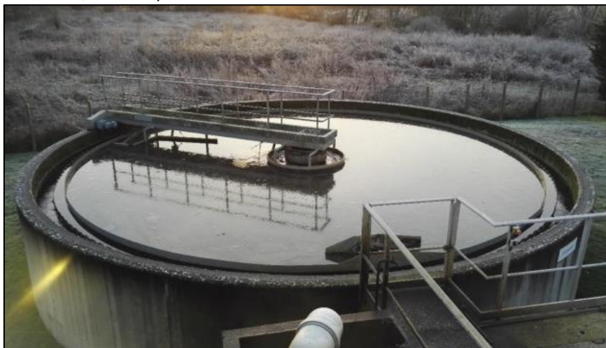
Figure 83 : Clarificateur (STEU Douchy Montcorbon)
