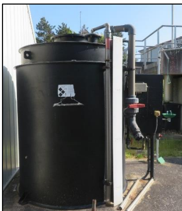
Figure 141 : Cuve de chlore ferrique -- STEU de Saint-Hilaire-les-Andrésis
