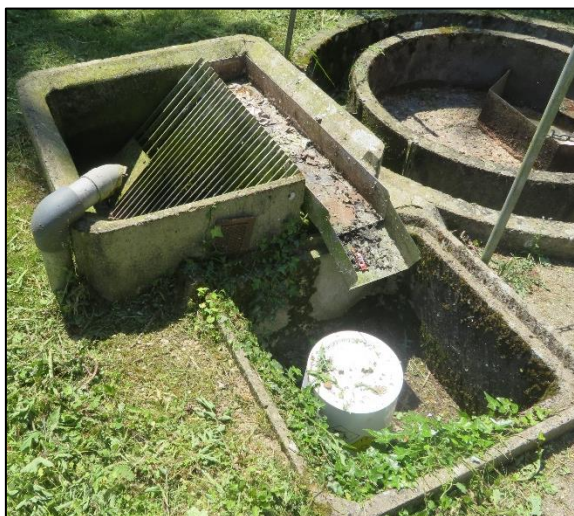
Figure 128 : Dégrillage - STEU de Saint-Firmin-des-Bois
