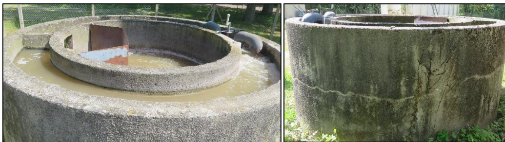
Figure 107 : Dessableur/Dégraisseur - STEU La Selle-sur-le-Bied
