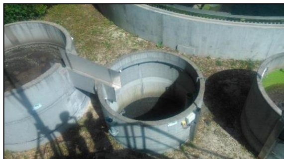
Figure 50 : Dégazeur et puits à flottant (STEU Château-Renard)
