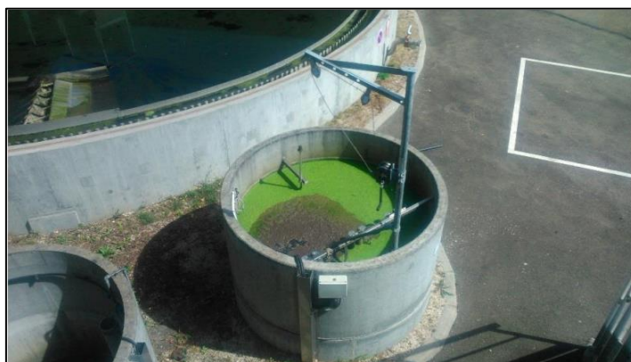
Figure 54 : Puits à boue (STEU Château-Renard)
