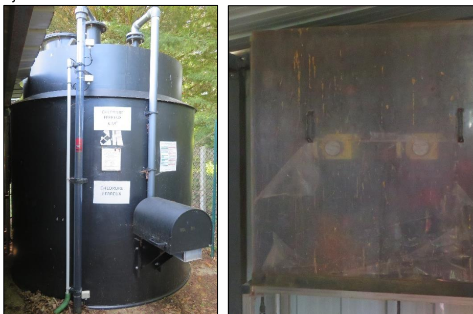
Figure 75 : Cuve de chlorure ferreux/ Pompes - STEU La Jacqueminière
