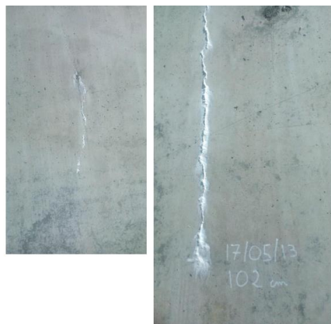
Figure 49 : Bassin d'aération avec fissures observées (STEU Château-Renard)
