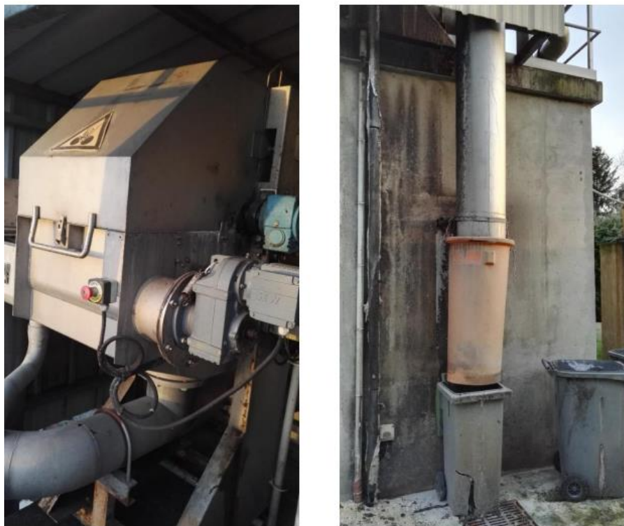
Figure 81 : Dégrilleur automatique (à gauche) et collecte des refus de dégrillage (à droite) (STEU Douchy Montcorbon)
