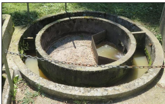
Figure 129 : Dessableur/Dégraisseur -- STEU de Saint-Firmin-des-Bois
