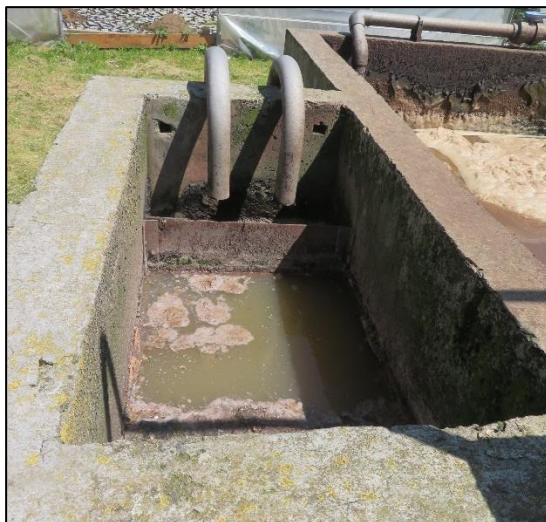
Figure 115 : Dessableur/Dégraisseur - STEU Melleroy
