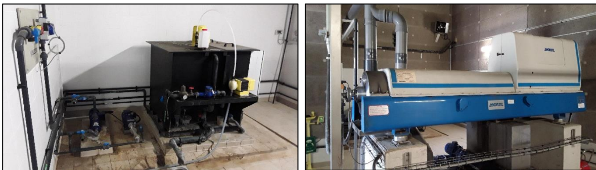
Figure 70 : Local centrifugeuse - STEU de Courtenay
