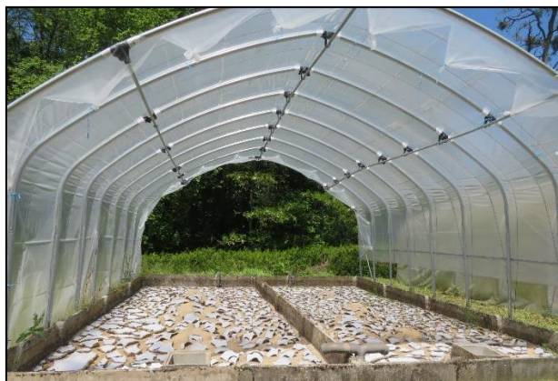
Figure 135 : Lits de séchage - STEU de Saint Firmin des Bois
