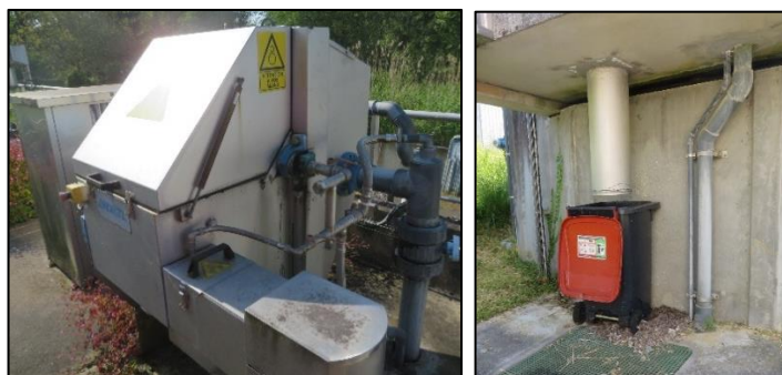
Figure 140 : Tamis rotatif -- STEU de Saint-Hilaire-les-Andrésis
