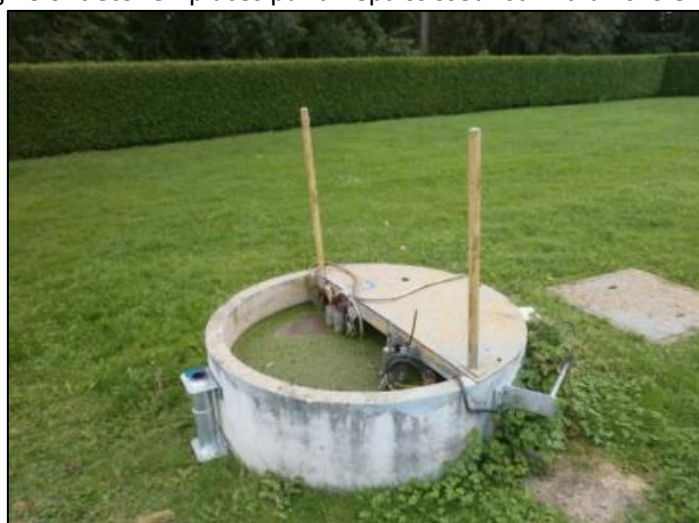
Figure 93 : Poste de recirculation des boues (STEU - Saint Germain des Prés)
