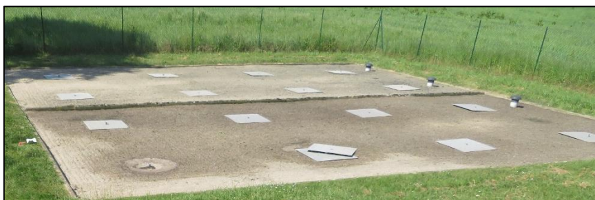
Figure 125 : Filtres à sable -- STEU de Mérimville
