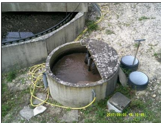
Figure 59 : Puits à boues (STEU Chuelles)
