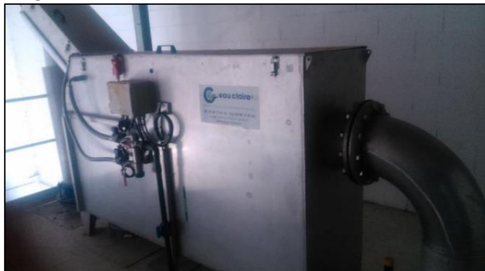
Figure 46 : Tamis rotatif (à l'arrêt le jour de la visite) STEU Château-Renard
