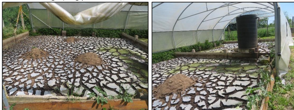
Figure 120 : Lits de séchage - STEU de Melleroy
