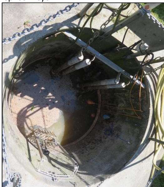
Figure 114 : Poste de relèvement et dégrillage - STEU Melleroy
