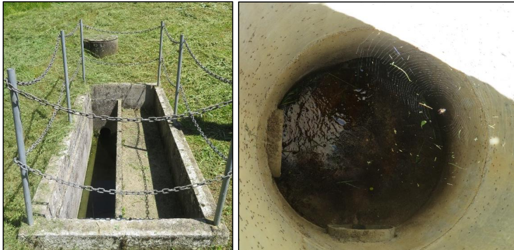
Figure 134 : Canal et regard de sortie - STEU de Saint-Firmin-des-Bois
