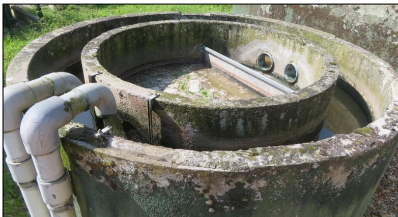
Figure 39 : Dessableur/Déshuileur – STEU de Chantecoq
