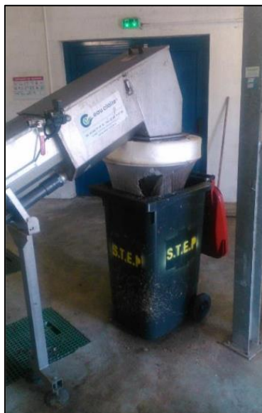
Figure 48 : Refus de dégrillage (STEU Château-Renard)
