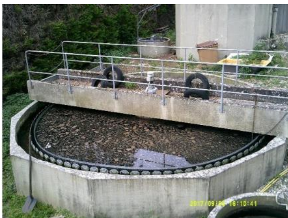
Figure 58 : Clarificateur STEU Chuelles)
