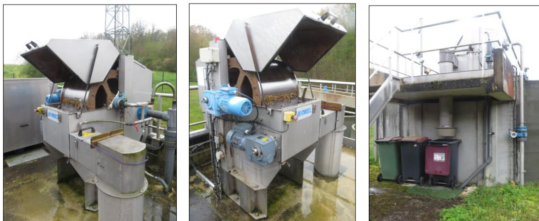
Figure 97 : Tamis rotatif et compacteur à déchets – STEU de La Selle-en-Hermoy
