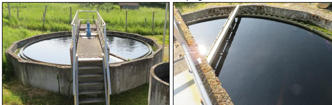
Figure 144 : Clarificateur -- STEU de Saint-Hilaire-les-André
