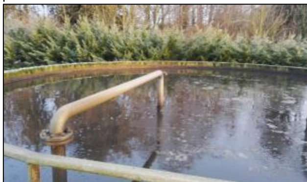
Figure 82 : Bassin d'aération (STEU Douchy Montcorbon)
