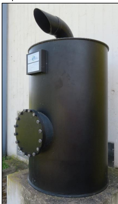
Figure 72 : Filtres à charbon actif – STEU de Courtenay
