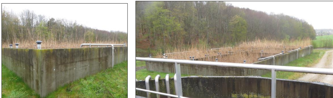
Figure 102 : Filtres plantés de roseaux – STEU de La Selle-en-Hermoy
