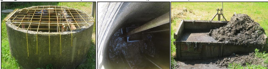
Figure 106 : Poste de relèvement et dégrillage - STEU La Selle-sur-le-Bied
