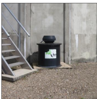
Figure 156 : Filtres à charbon actif – STEU de Triguères
