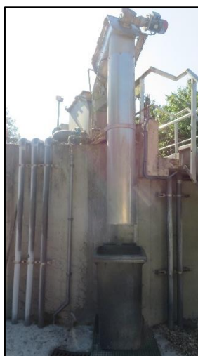
Figure 30 : Tamis rotatif – STEU de Bazoches sur le Betz
