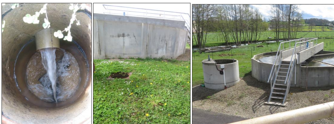
Figure 153 : Regard de rejet des eaux traitées – STEU de Triguères
