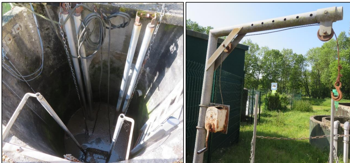
Figure 38 : Poste de relèvement STEU de Chantecoq
