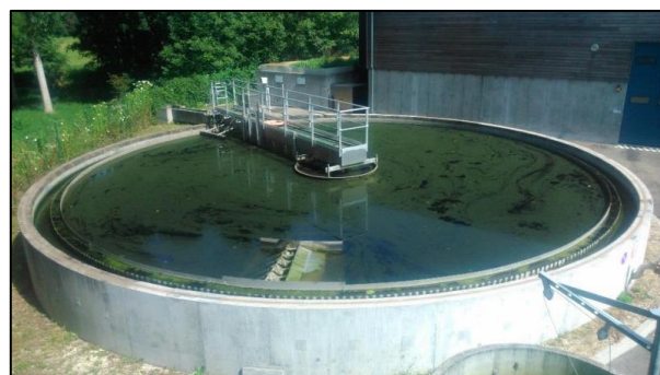
Figure 51 : Bassin d'aération avec présence anormale d'algues (STEU Château-Renard)
