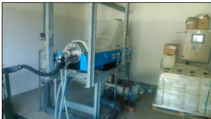
Figure 53 : Centrifugation des boues (STEU Château-Renard)
