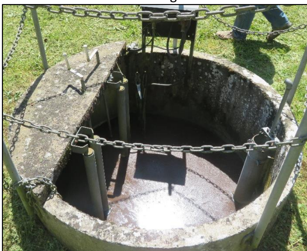
Figure 132 : Dégazage et recirculation - STEU de Saint-Firmin-des-Bois
