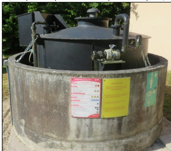
Figure 31 : Poste de déphosphatation – STEU de Bazoches sur le Betz
