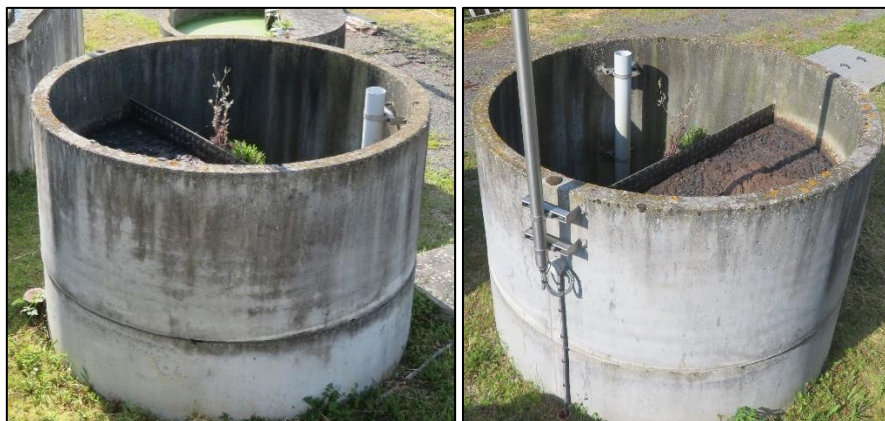
Figure 143 : Dégazage/Puits à mousse- STEU de Saint-Hilaire-les-André
