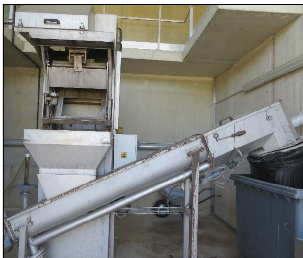
Figure 62 : dégrilleur automatique – STEU de Courtenay
