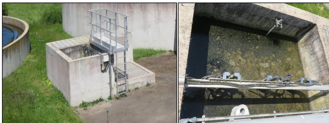
Figure 67 : Dégazeur et poste de colature – STEU de Courtenay
