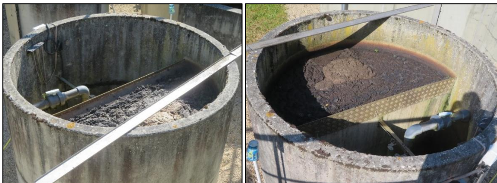
Figure 33 : Dégazeur et clarificateur – STEU de Bazoches sur le Betz
