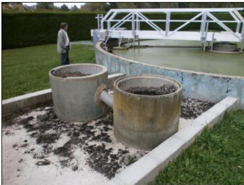
Figure 90 : Dégazeur et stockage des flottants (STEU - Saint Germain des Prés)
