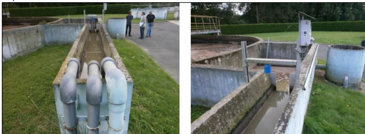
Figure 88 : Canal de dessablage (STEU - Saint Germain des Prés)
