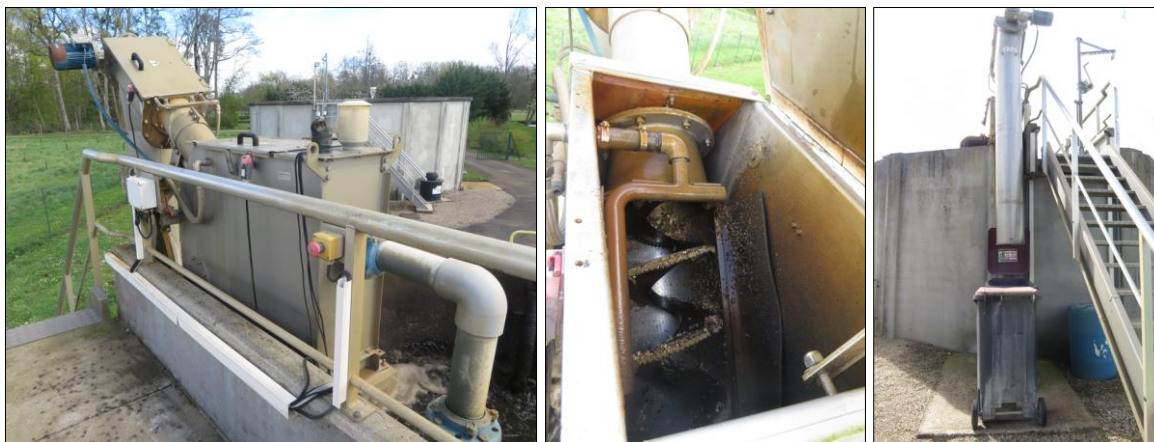
Figure 149 : Tamis rotatif – STEU de Triguères
