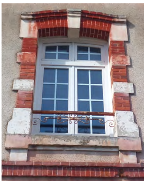
Le garde-corps en fer soudé vu de l'extérieur et de l'intérieur.
