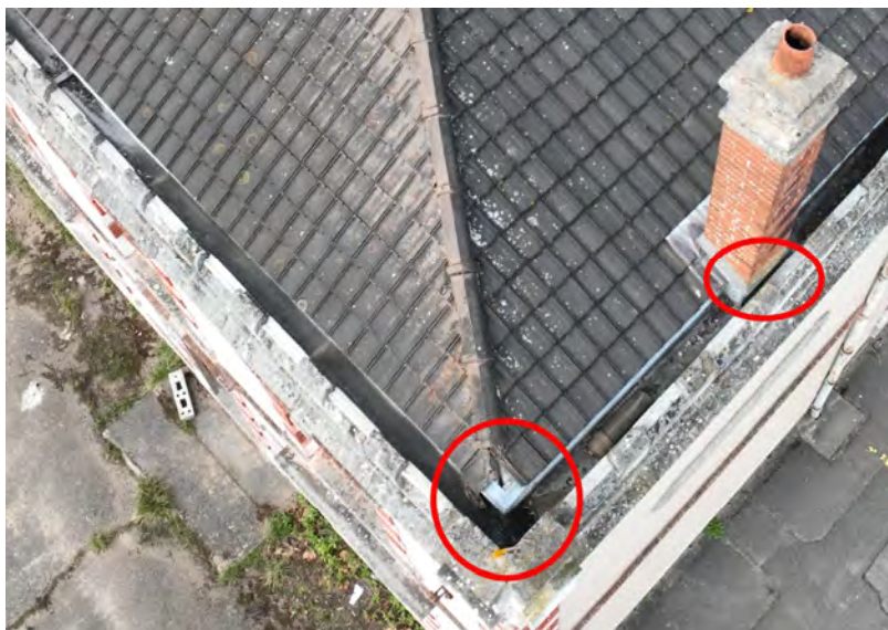
Vue angle Sud Est de la toiture – un about l'arêtier n'est plus à sa place La souche de la cheminée de rive entrave le bon écoulement de l'eau
