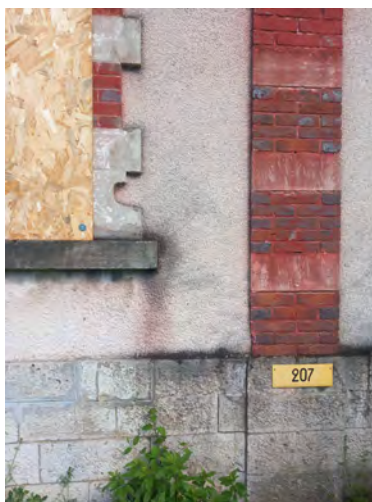
Détail du pilastre de la façade Ouest Le badigeon coule et se délave
