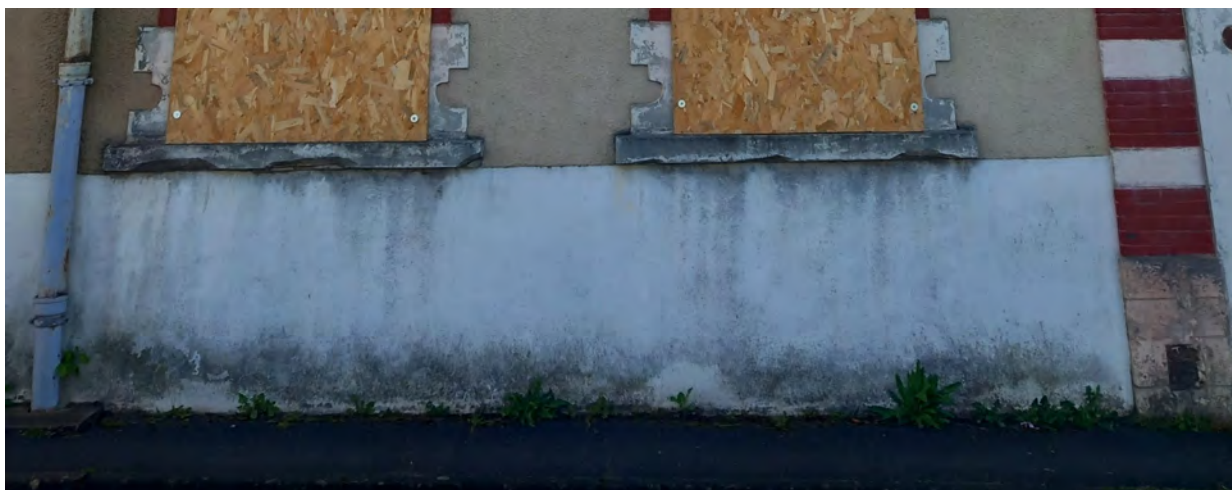
Photo sous bassement de la façade Est -traité en enduit de ciment.
