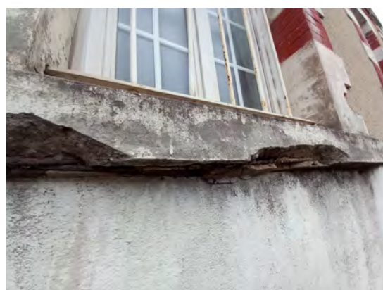
Eclatement des pièces d'appuis en béton armé : fenêtres jumelées de la partie ancienne – et de nombreuses autres fenêtres de l'extension 1930.
