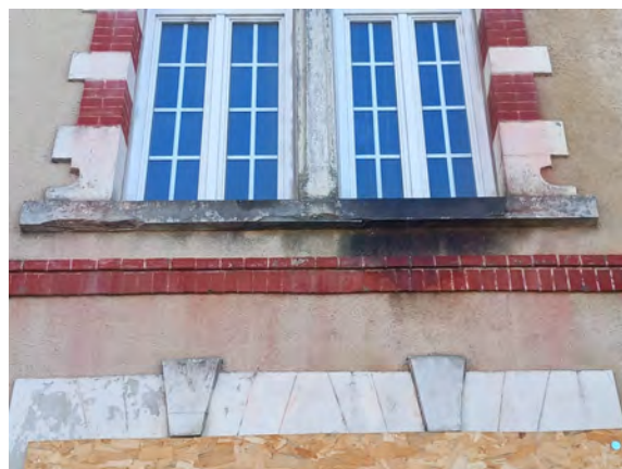
Salissure et dégradation en dessous d'une pièce d'appui d'une fenêtre à l'étage de la façade Est.
