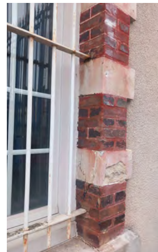
Les trous de vissage auraient pu être placés au milieu des joints. Certains percements ont provoqués l'éclatement de certaines pierres.
