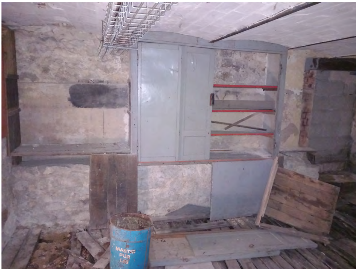
Vue de la pièce -1-2 , avec le sol de planches posées sur lambourdes sur la terre
