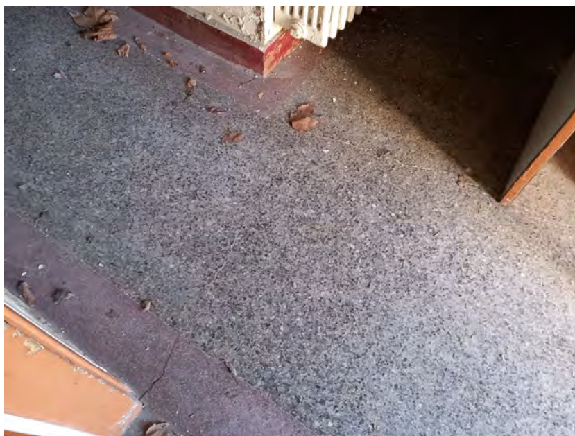
L'état du sol en Granito, avec les quelques fissures qu'il faudra savoir réparer.
