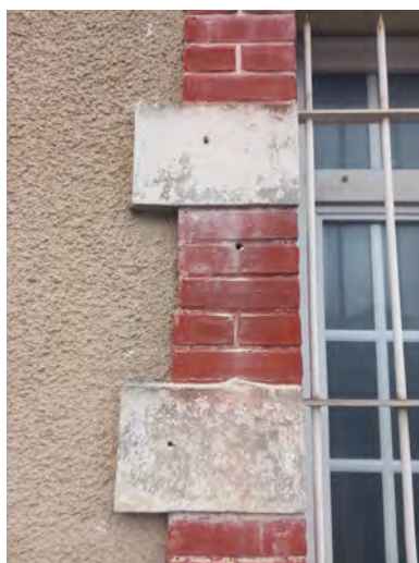
Les trous de vissage auraient pu être placés au milieu des joints. Certains percements ont provoqués l'éclatement de certaines pierres.
