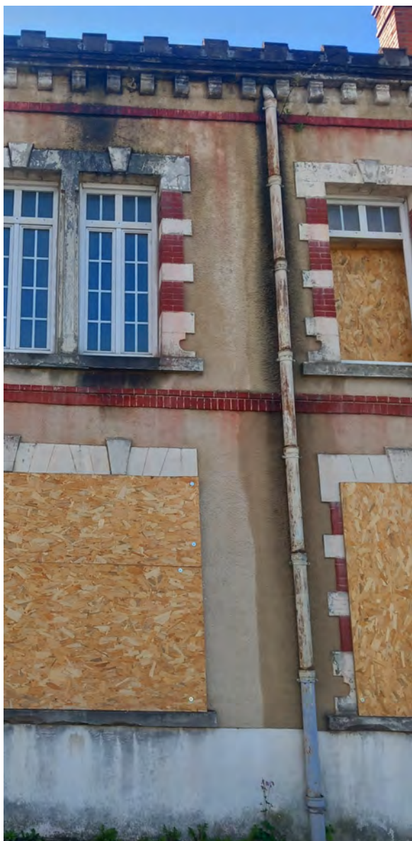
Tuyau de descente en fonte sur la façade Est
