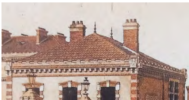
Photo de 1914 du pavillon d'entrée Nord Les tuiles de type Marseille et épis en terre cuite
