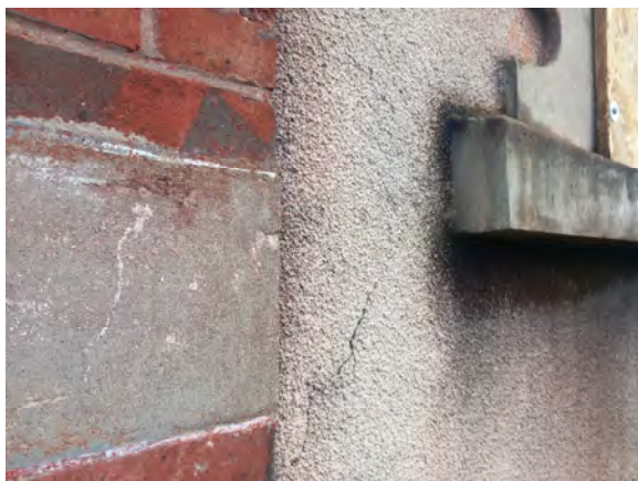
Profil de pièce d'appui en béton d'une fenêtre au rez-de-chaussée de la façade Ouest
