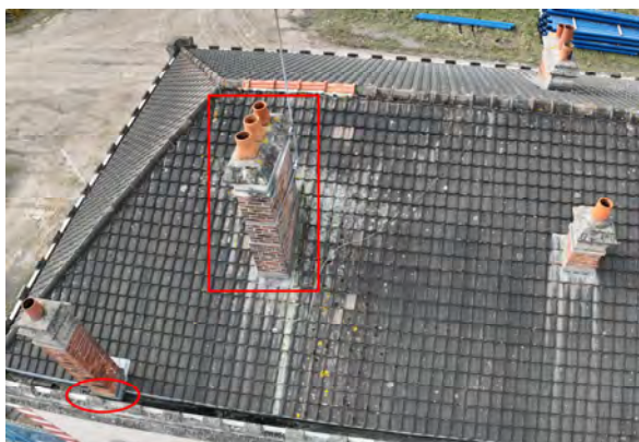
Les 4 cheminées en brique avec couronnement en pierre situées au Sud & les deux cheminées en brique au Nord
