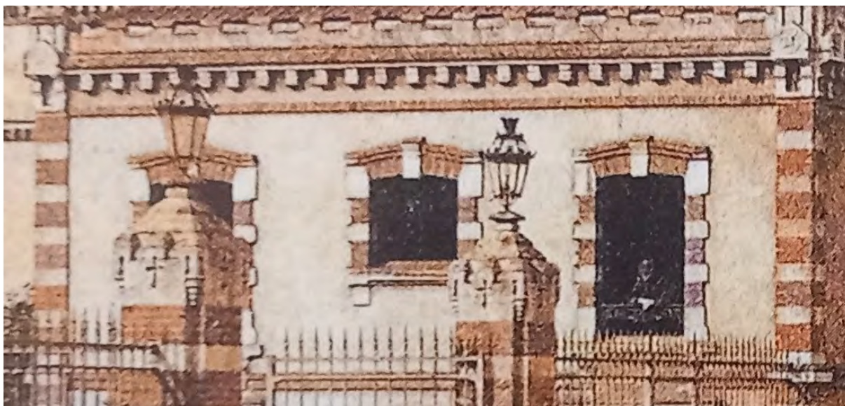
Photos de 1914 – la fenêtre du milieu est plus petite de ses voisines. Son appui est plus haut. Les fenêtres sont dotées de garde-corps en fonte.
