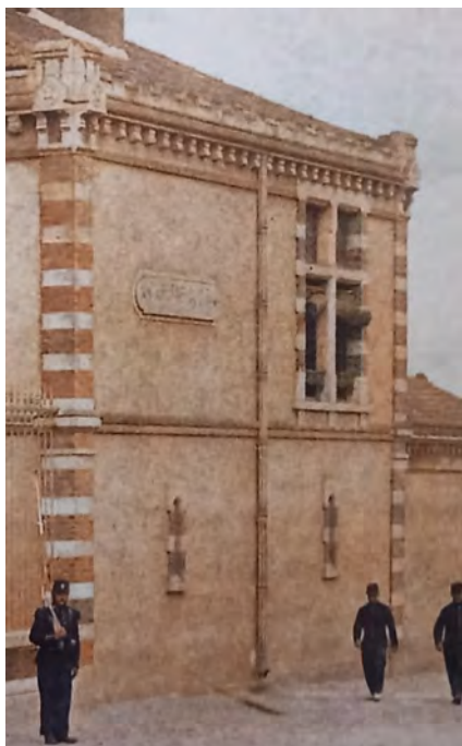
Photos de 1905 - tuyau en fonte avec motifs de cannelures.
