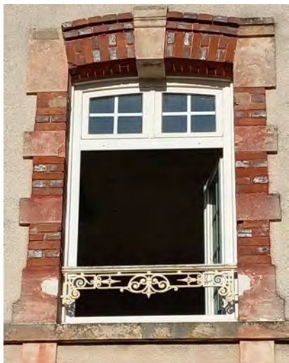
Photos du garde-corps en fonte du pavillon d'entrée Sud encore en place aujourd'hui.
