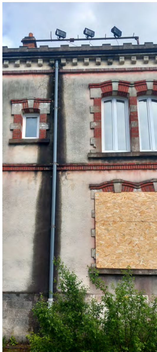
Tuyau de descente en zinc avec dauphin en fonte sur la façade Ouest
