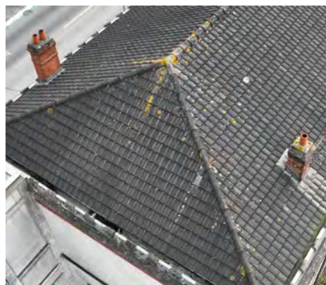
Les 4 cheminées en brique avec couronnement en pierre situées au Sud & les deux cheminées en brique au Nord
