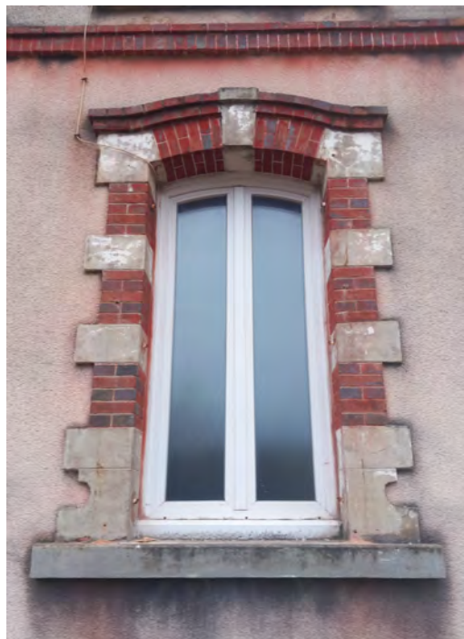
Baie de fenêtre - façade Ouest – extension - 1930 brique & fausse pierre (ciment)
