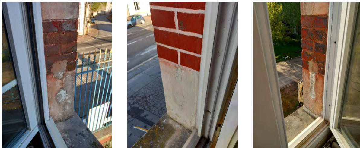
Photos des fenêtres à l'étage de la partie d'origine—On remarque les traces de scellement des anciens garde-corps.
