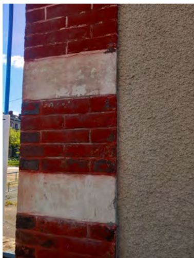
Détails de l'angle de murs Sud Est avec badigeons et décor de joint
