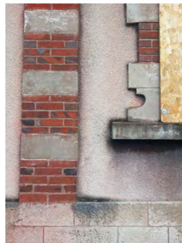
Détail d'un pilastre nord. il ne reste plus de traces de badigeon
