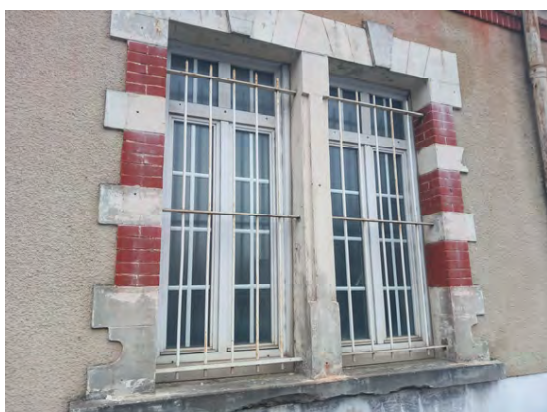
Eclatement des pièces d'appuis en béton armé : fenêtres jumelées de la partie ancienne – et de nombreuses autres fenêtres de l'extension 1930.
